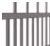
Espace réduit par rajout de tubes dans le soubassement
